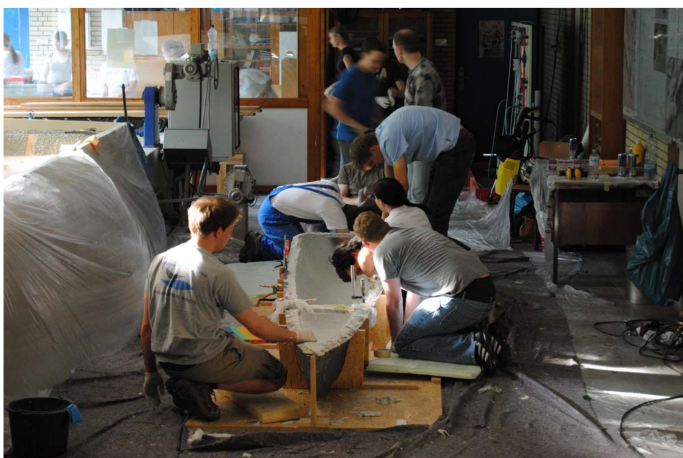
Anbringen der Randschalung
