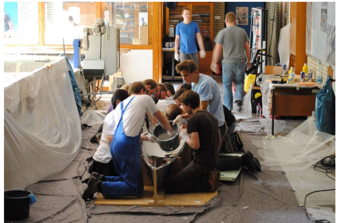
Einbringen des Beton I
