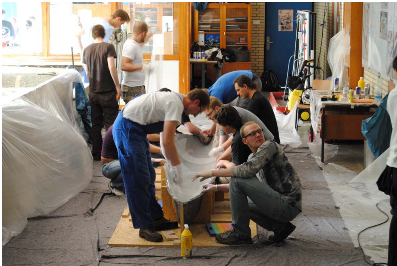
Vorbereitung der Bewehrung
