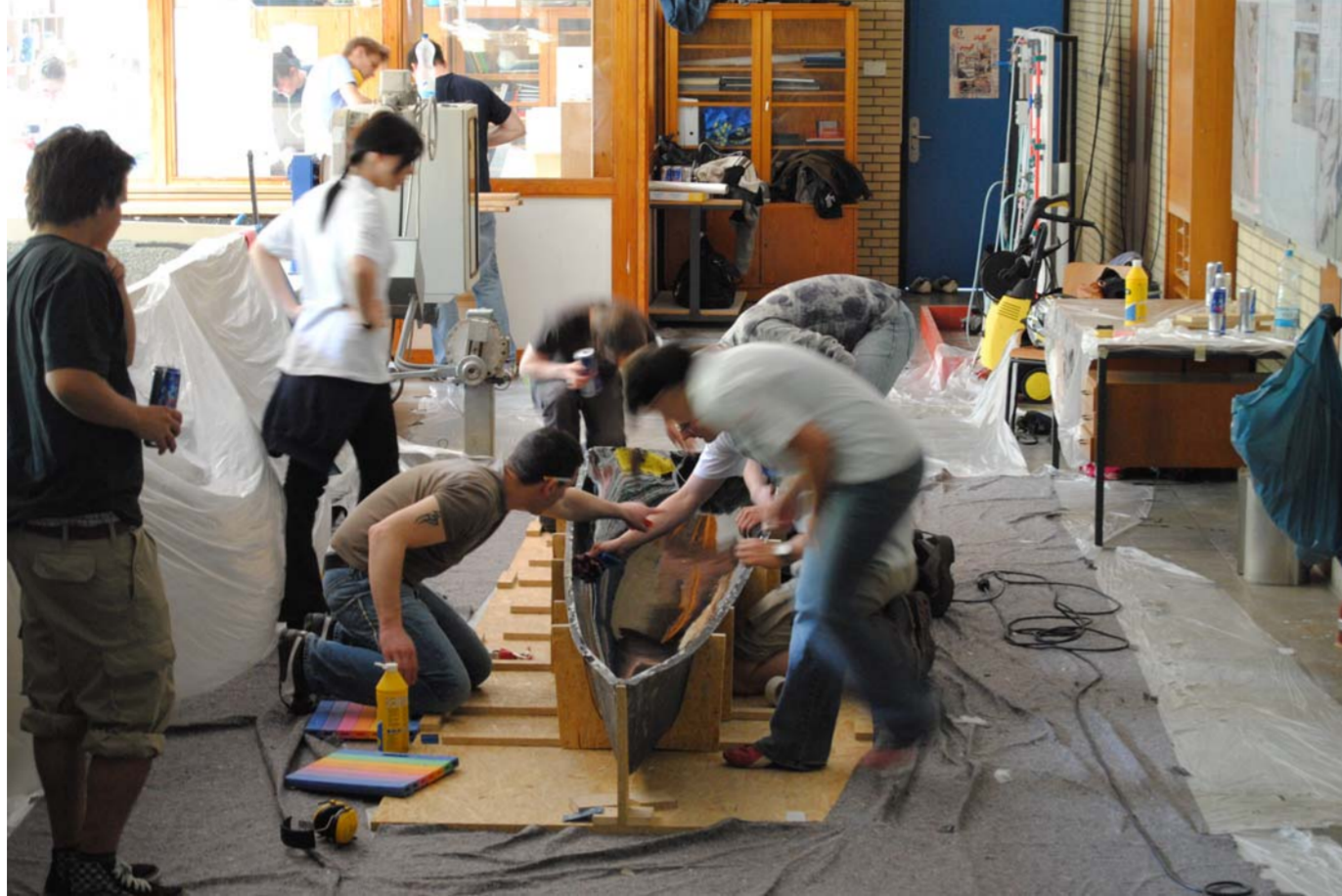
Vorbereitung der Schalung
