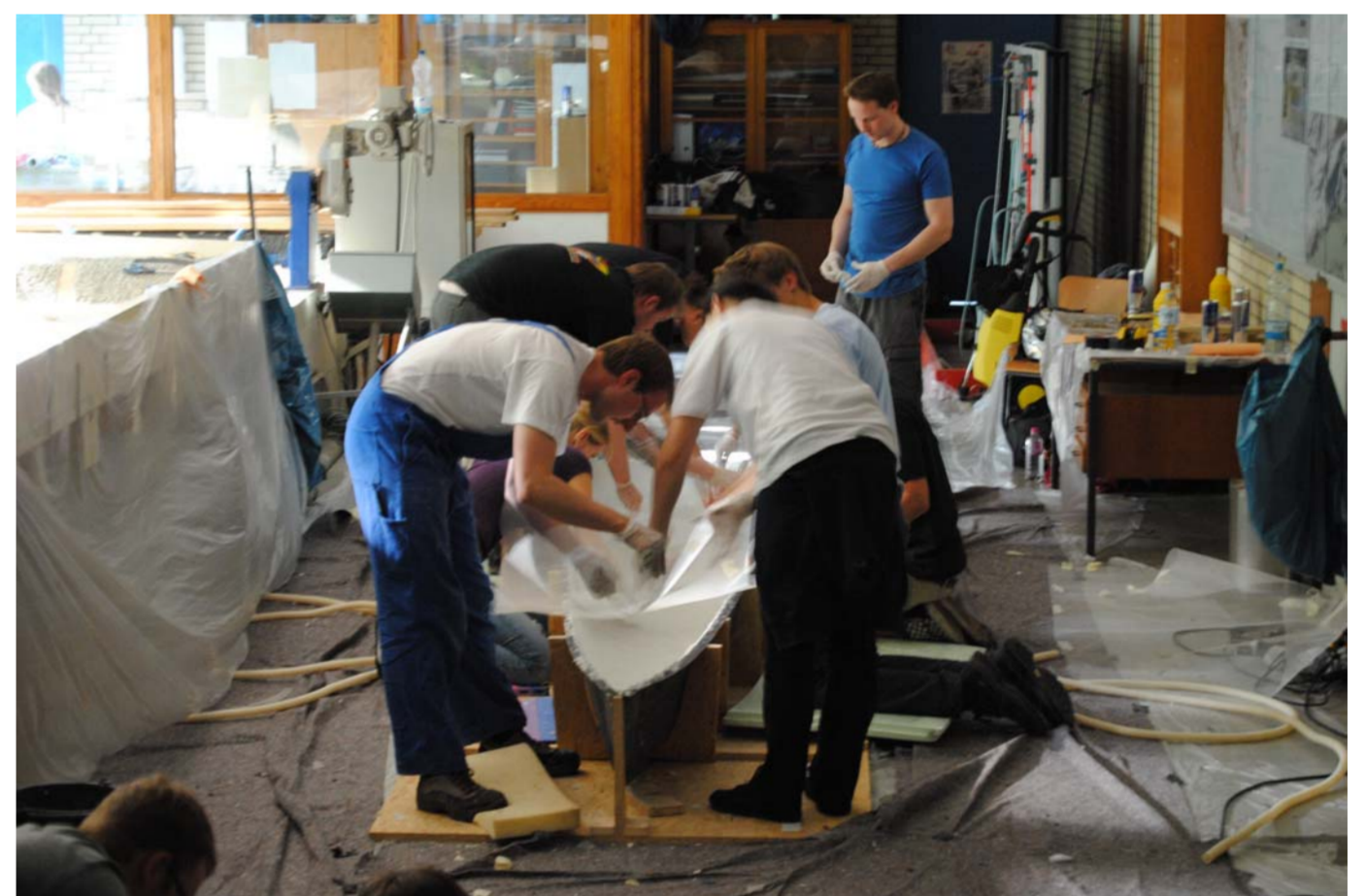
Einbringen der Bewehrung
