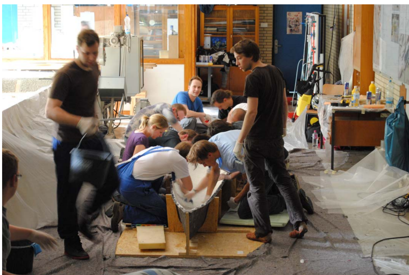
Einbringen des Beton II
